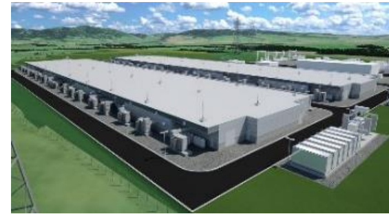
2018 世界最大級の蓄電池システムプロジェクト 北海道、日本
