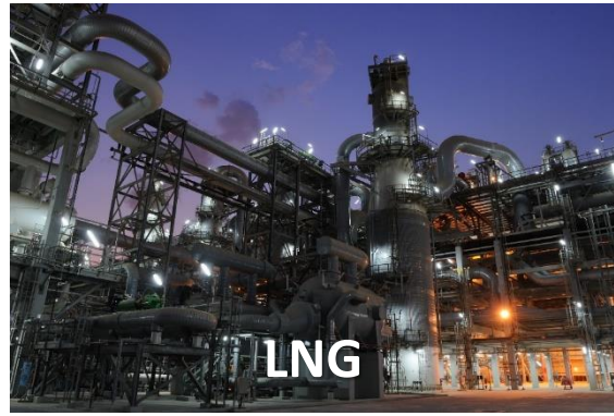
2004 カタールガス社のLNGプラント、カタール
